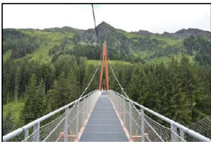
Passerelle en fer avec haubans.
