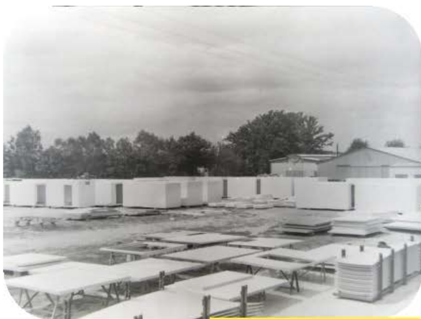
Les caissons frigorifiques à Theillay
