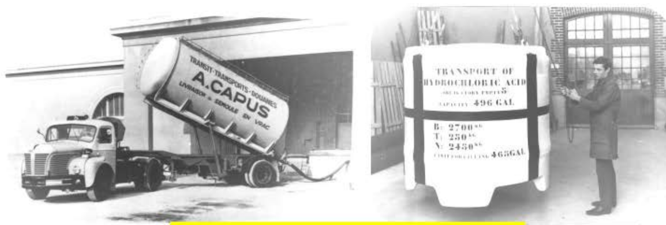
Des citernes en composite, faites en enroulement filamentaire
